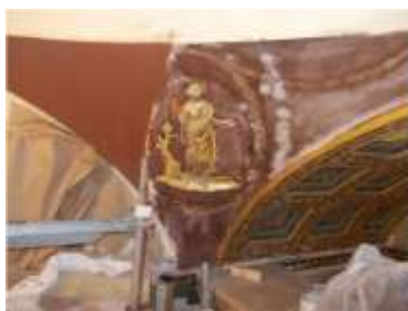
Илл. 40-41. Консервации и реставрации штукатурного слоя фона, лепного декора с позолотой и окраской фона с сохранением гирлянды, выявленной после удаления поздних слоёв краски на северо-западном парусе свода купола. 2011-2012 годы
