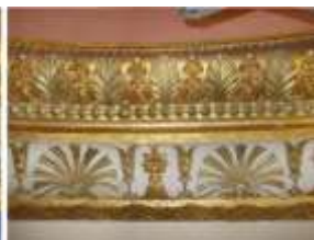
Илл. 44-45. Овальный кабинет. Фрагмент карниза после консервации и реставрации с выявленным после удаления загрязнений цветным золотом жёлтого и зелёного цветов. 2011 год
