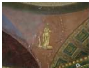
Илл. 38-39. Яшмовый кабинет. Северо-западный парус до реставрации. Парус в процессе удаления поздних красочных слоёв на фоне
