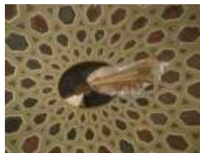
Илл. 46-47. Овальный кабинет. Пробойна в купольной части со времён войны 1941-1944 годов. Заделка пробойны лагами из древесины сосны и обшивка дранкой перед нанесением штукатурного слоя грубой фракции и гипсовой затиркой 2012 год
