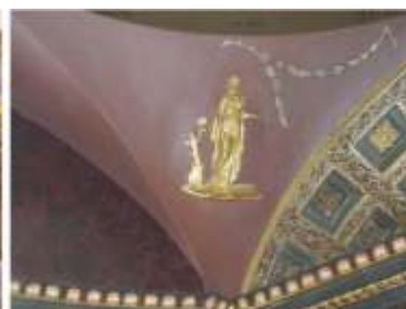
Илл. 40-41. Консервации и реставрации штукатурного слоя фона, лепного декора с позолотой и окраской фона с сохранением гирлянды, выявленной после удаления поздних слоёв краски на северо-западном парусе свода купола. 2011-2012 годы
